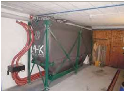
Abb. 10b: Trog silo mit mehreren Saugentnahmepunkten
